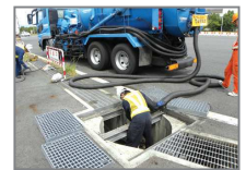
清掃作業の状況
