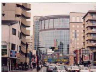
熊本電鉄ビル新築工事 熊本県 H9.03
