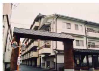
公営住宅中耐C棟建築工事 熊本県 H8.12
