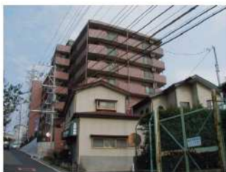
飯田マンション新築工事 神奈川県 H12.10
