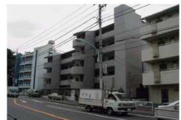
住友生命相互小金井市社宅改築工事 東京都 H12.2
