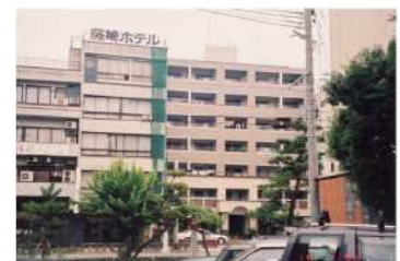
向井商会ビル新築工事 熊本県 H8.9
