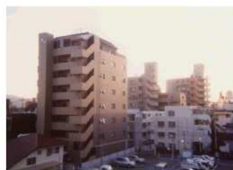
ラ・フォーレ城西新築工事 福岡県 H12.4
