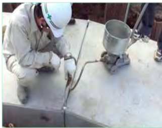
注入口より側壁部・底版部へ注入 (曲線部)
