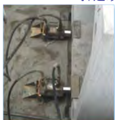
ジャッキによる押し込み状況
