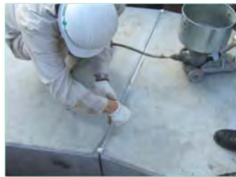
上部より頂版天端部へ注入 (曲線部)
