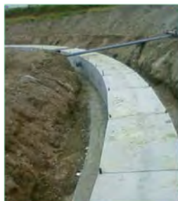
曲線部も直線部と同じ施工！
